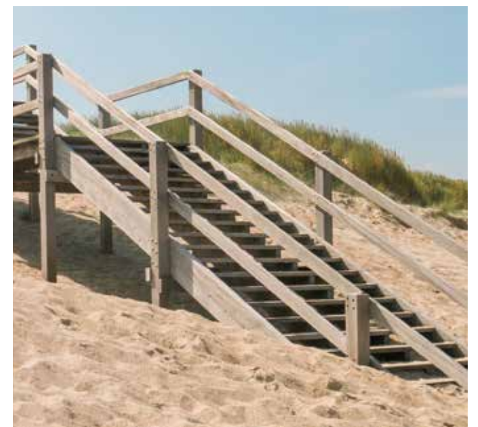
"Door het prijsverschil tussen FCS- en niet-FSC-hout (FSC-hout is tot twintig procent duurder) proberen aannemers al te vaak kosten uit te sparen door bewust geen FSC-hout te gebruiken, soms zelfs tegen de richtlijnen van het bestek in", weet Myriam Azarkan. "Dit werkt oneerlijke concurrentie in de hand."
